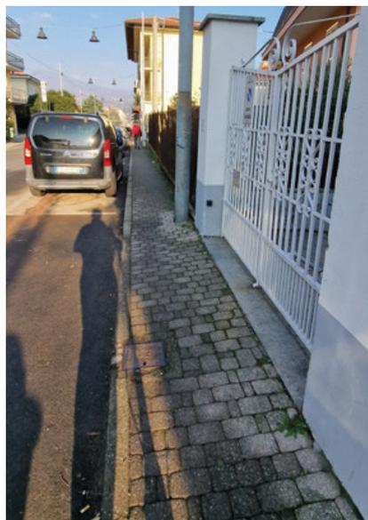
Descrizione prestazionale possibile intervento: Rifacimento del marciapiede o percorso pedonale esistente previa demolizione della pavimentazione compreso il sottofondo, allo scopo di assicurare un percorso continuativo con pendenza trasversale non superiore all'1%
