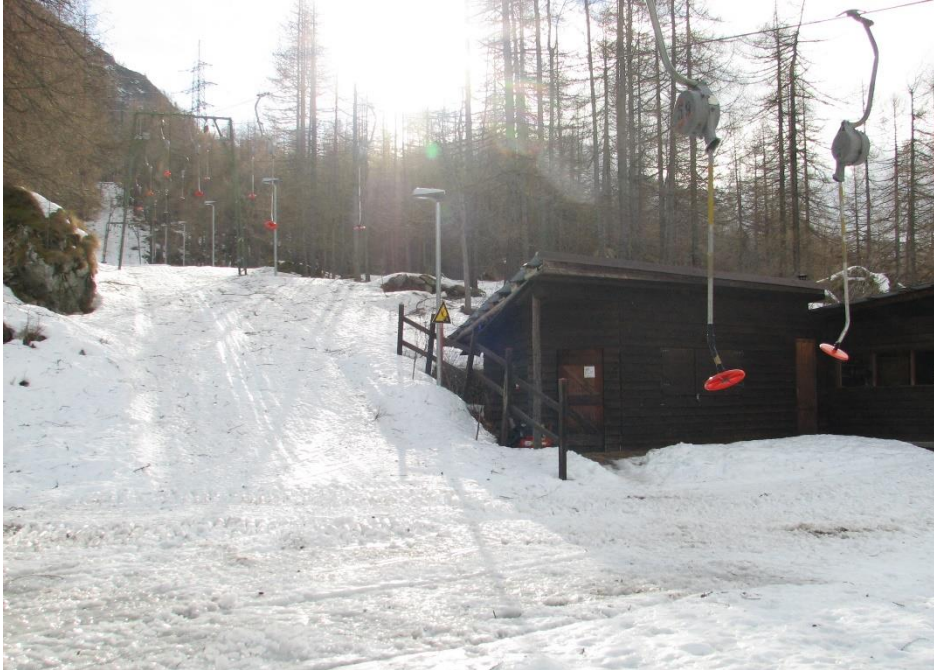
Fig. 4: Stazione di valle, tracciato e locale adibito a magazzino manutenzione
