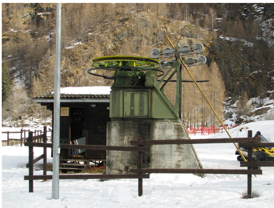
Fig. 3: Fotografia stazione di valle: motore e puleggia, locale di comando
