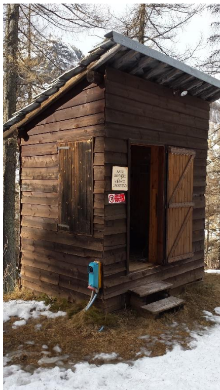
Fig. 8: Locale di comando di monte
