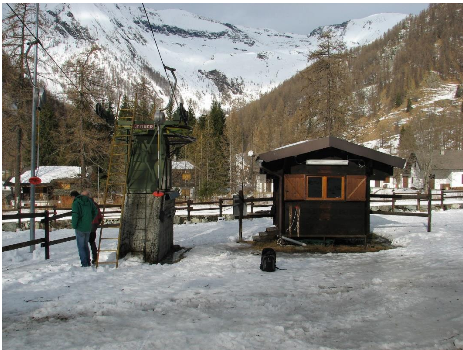
Fig. 2: Fotografia stazione di valle: motore e puleggia, locale di comando
