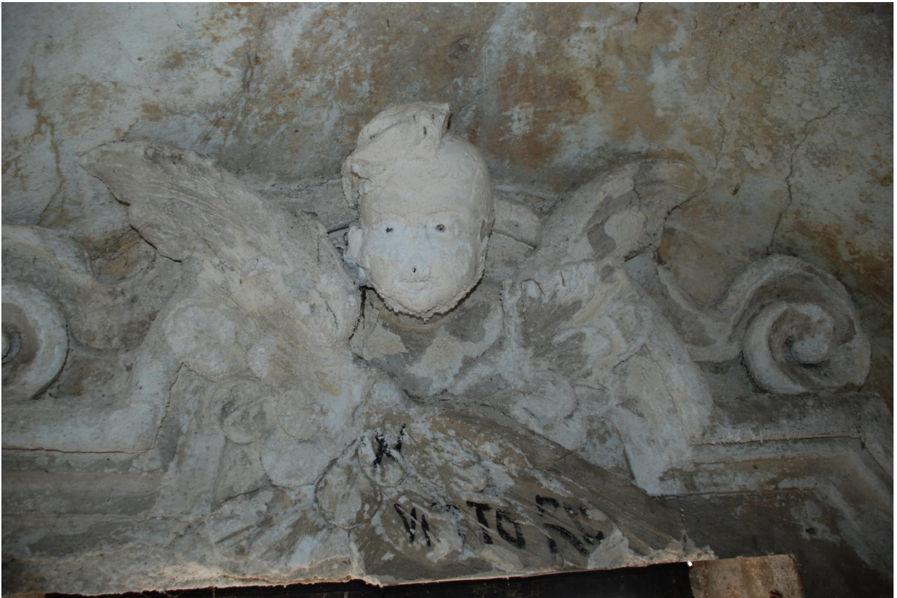
Degrado degli stucchi invasi da formazione saline
